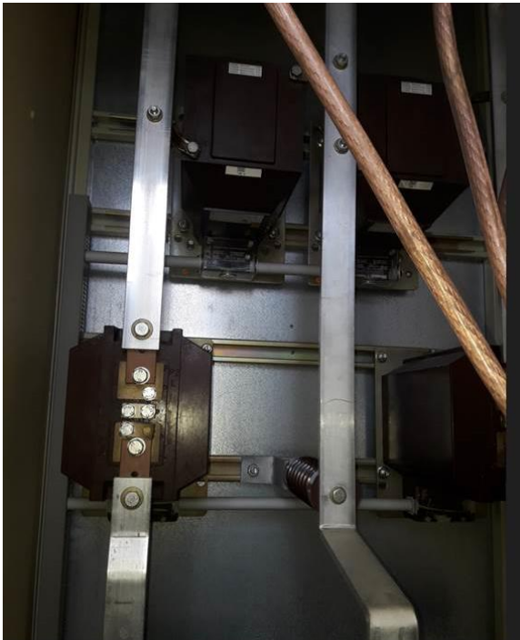
Umbau einer Aron-Schaltung
